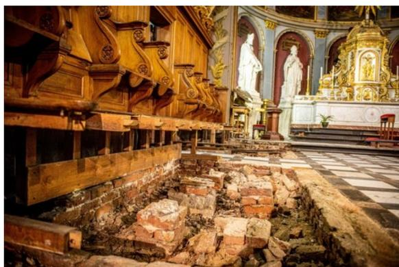
*Les stalles du chœur attaquées par l'humidité, ont dû être retirés*
